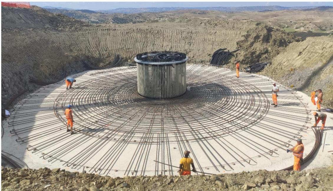
**Figura 3-3: immagine tipo posa anchor cages**
