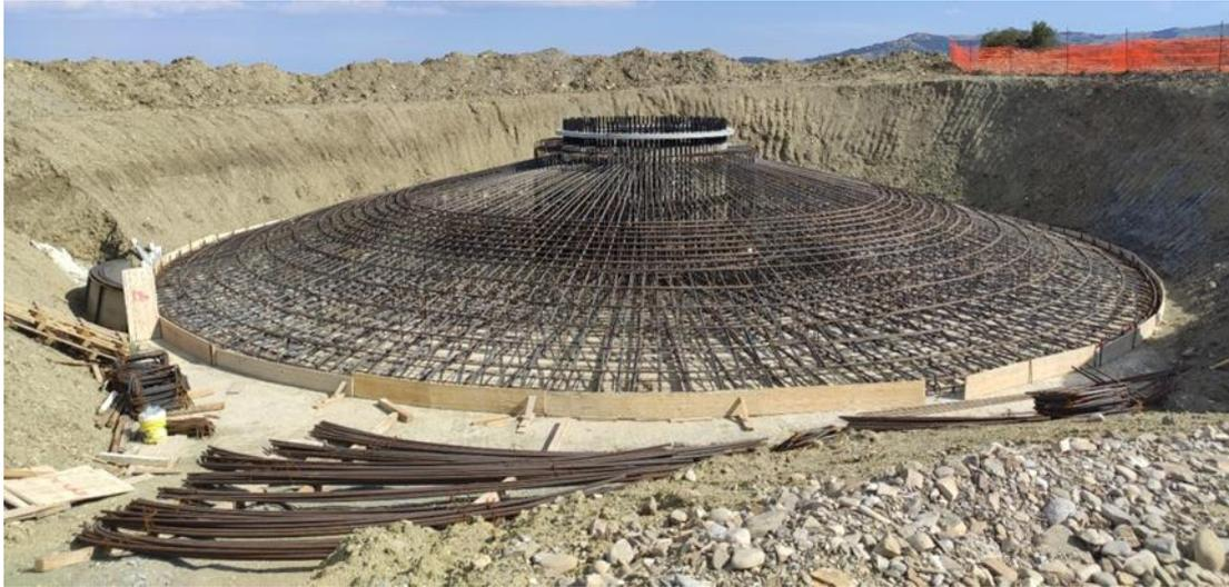
**Figura 3-4: immagine tipo armature plinto**
