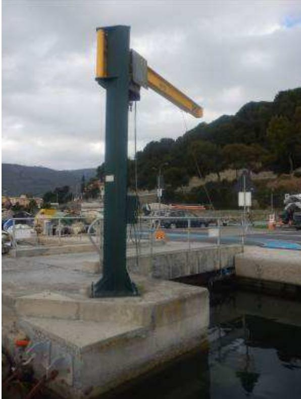
L'attuale gru di alaggio per piccole imbarcazioni ha una capacità di sollevamento fino a 480 kg. Si prevede di installare una nuova gru con portata fino a 1.000 kg. Per portate maggiori si impiegherà il travel-lift previsto nell'angolo sud-ovest del Porto.
