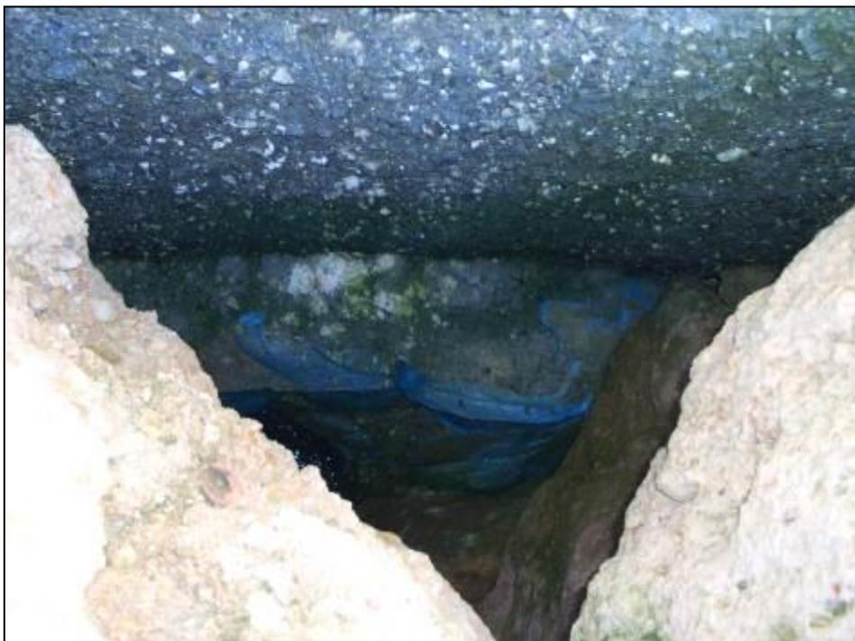
Zona rimasta integra a seguito di un intervento simile a quello di progetto realizzato con sacchi il nylon riempiti con calcestruzzo pompato. A distanza di 32 anni ( foto del 2020 ) circa sono ancora visibili i sacchi in plastica che hanno costituito il cassero per il getto.
