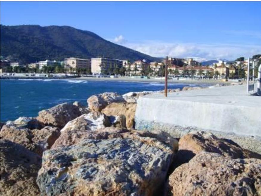
Angolo Sud – Ovest del muro paraonde e scogliera realizzata con massi in prevalenza di 4<sup>a</sup> Cat. ( con peso medio di 10 ÷ 12 t/cad.)
