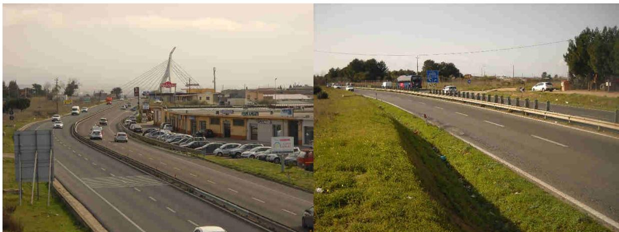
Figura 2 – Vista dell'infrastruttura attuale. Sezione con banchina laterale (a sinistra, km.4 circa) e senza banchina laterale (a destra, km.7 circa)
