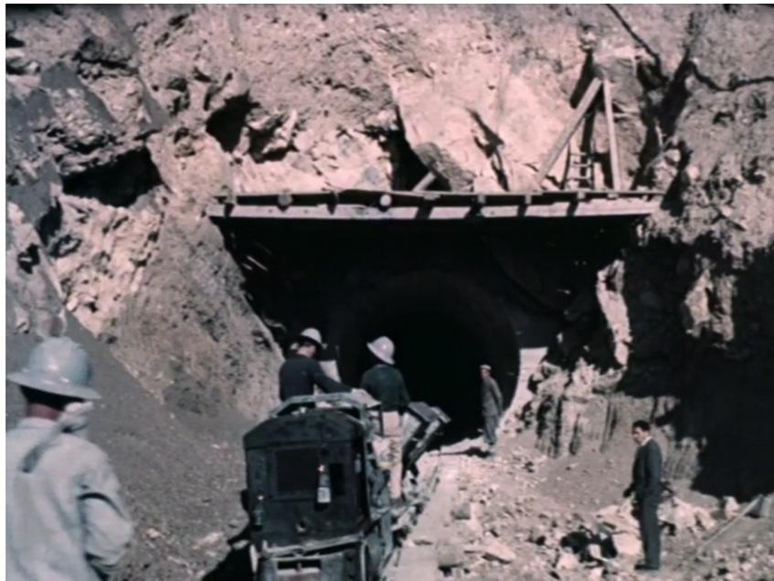
**Figura 15 - Fotogramma tratto dal filmato dell'Istituto Luce relativo alla realizzazione dell'opera. Foto dell'imbocco della galleria di fondo della diga del Pozzillo. Questa porzione del bacino è attualmente coperta dai depositi lacustri di colmata.**
