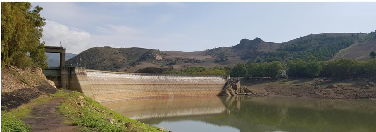
**Figura 8 - panoramica della sponda destra del Lago Pozzillo. Si noti il banco quarzarenitico sul quale è realizzata la spalla della diga.**
