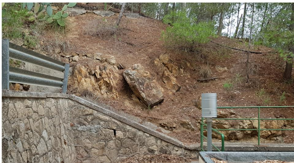
**Figura 14 - Famiglia di giunti N115°, 65°-85° molto ricorrente negli affioramenti in sinistra della diga, al punto da confondersi con la giacitura degli strati. Lungo questi piani di discontinuità paralleli al versante si innescano fenomeni gravitativi che causano rotazione locale dei blocchi e detensionano l'ammasso roccioso.**
