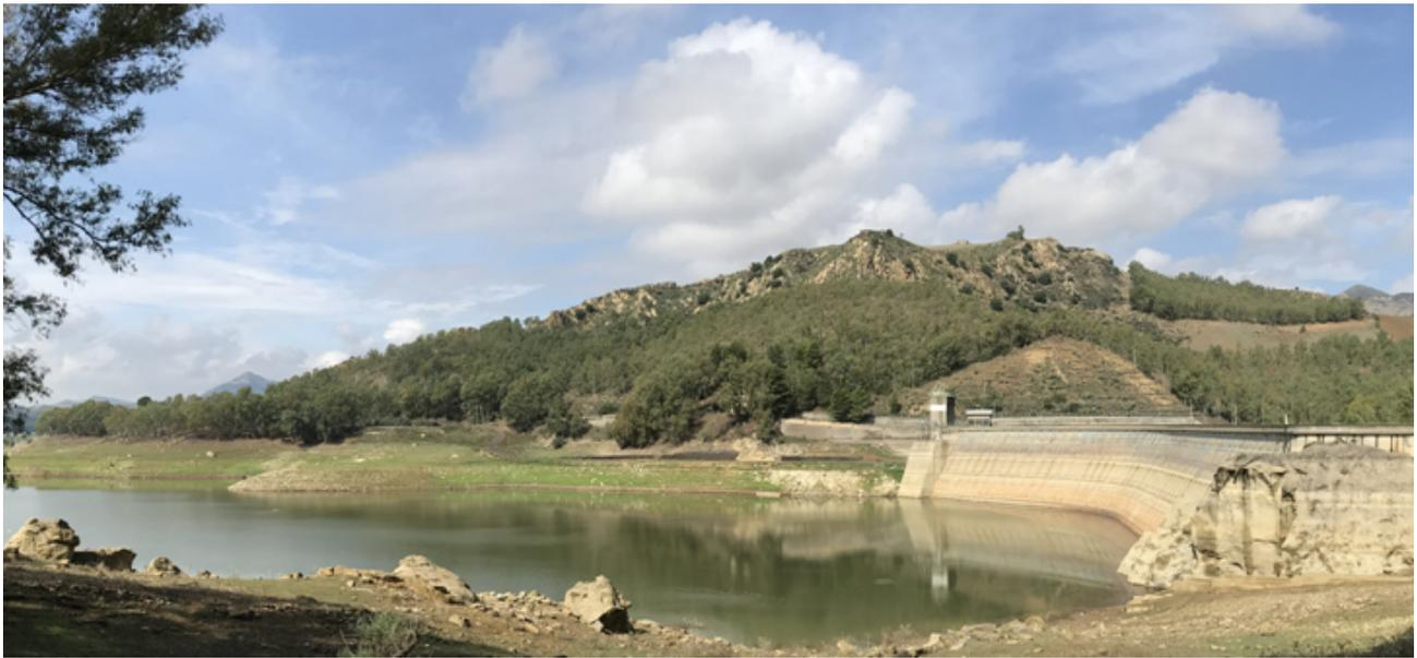
**Figura 9 - panoramica in sinistra con, sullo sfondo, il Pizzo. Nella foto si osserva l'affioramento sei banchi quarzarenitici su entrambe le spalle della diga. Sulle cornici alte di Pizzo Pollaro si può notare come la struttura ad antiforame rovesciata (con asse immergente verso sinistra), sia interessata da numerosi complicazioni alla mesoscala, con una serie di pieghe frammentate da piani associati a basso angolo tipo break thrust e fault progradation fault.**
