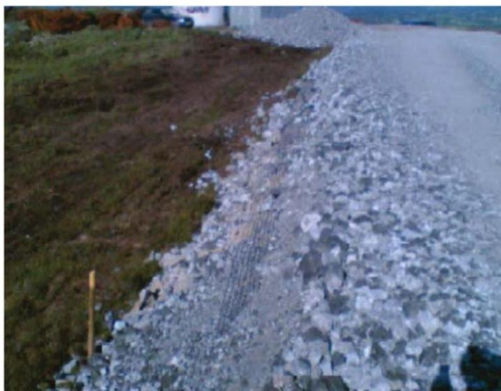
Figura 30 - Superficie stradale in misto stabilizzato e drenaggio
