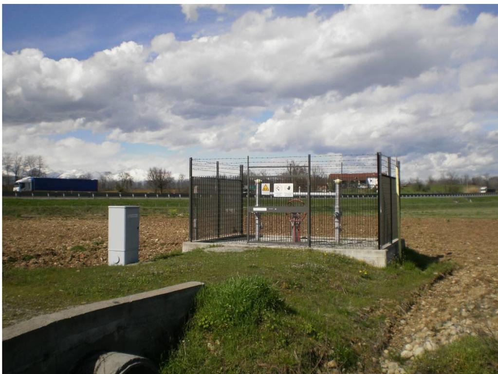
**Figura 5 - Esempio di impianto di intercettazione di linea PIL.**
