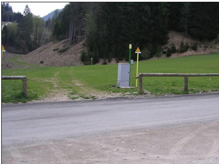
**Figura 6 - I cartelli segnalatori del metanodotto ed i tubi di sfiato posti in corrispondenza degli attraversamenti eseguiti con tubo di protezione.**
