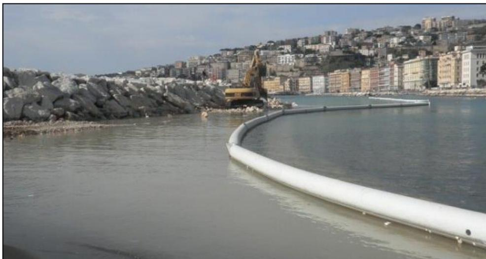
Figura 3-2 – Utilizzo di barriere anti-torbidità durante i lavori
