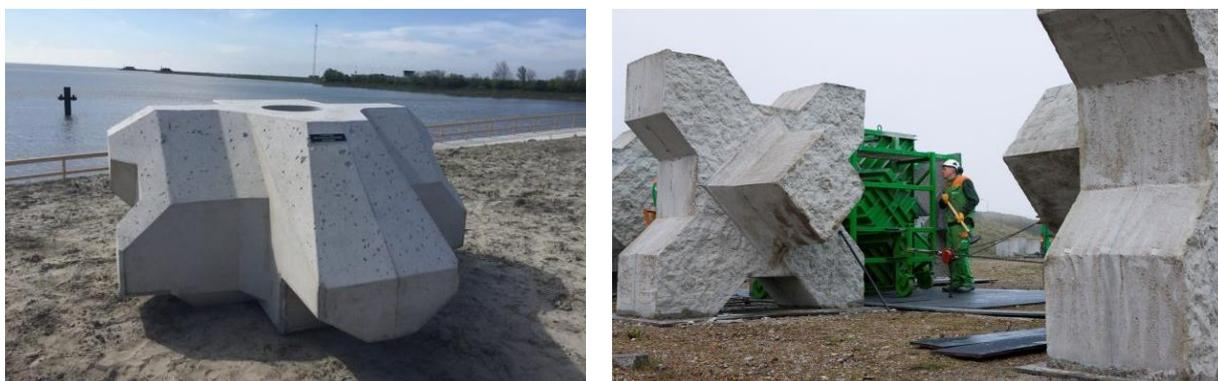
Figura 2.5 Massi artificiali Xbloc Plus® e Xbloc®
