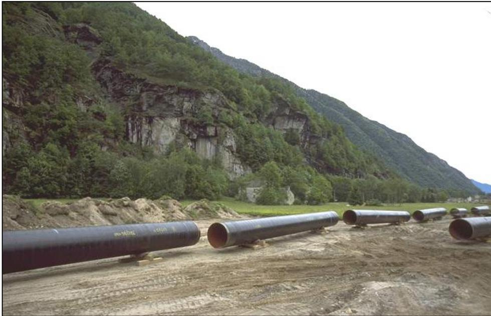
**Fig. 9.1/C: Sfilamento tubi**
