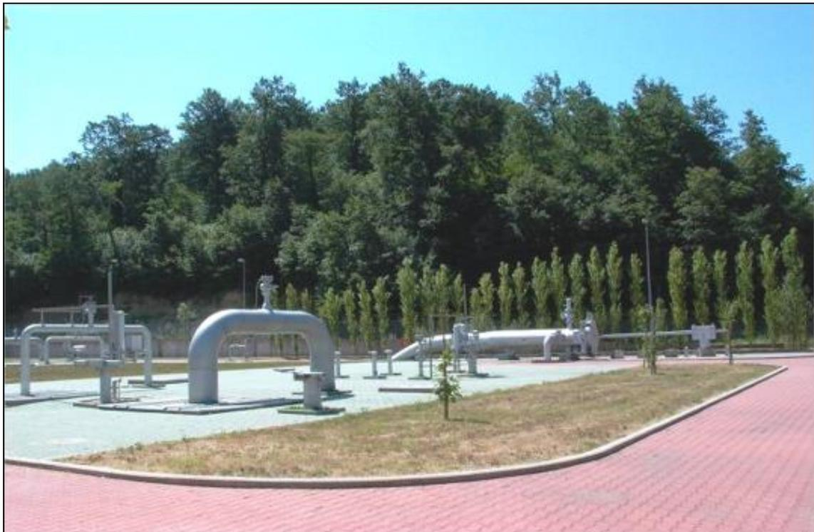
**Fig. 9.1/M: Installazione tipo stazione di lancio e ricevimento PIG**
