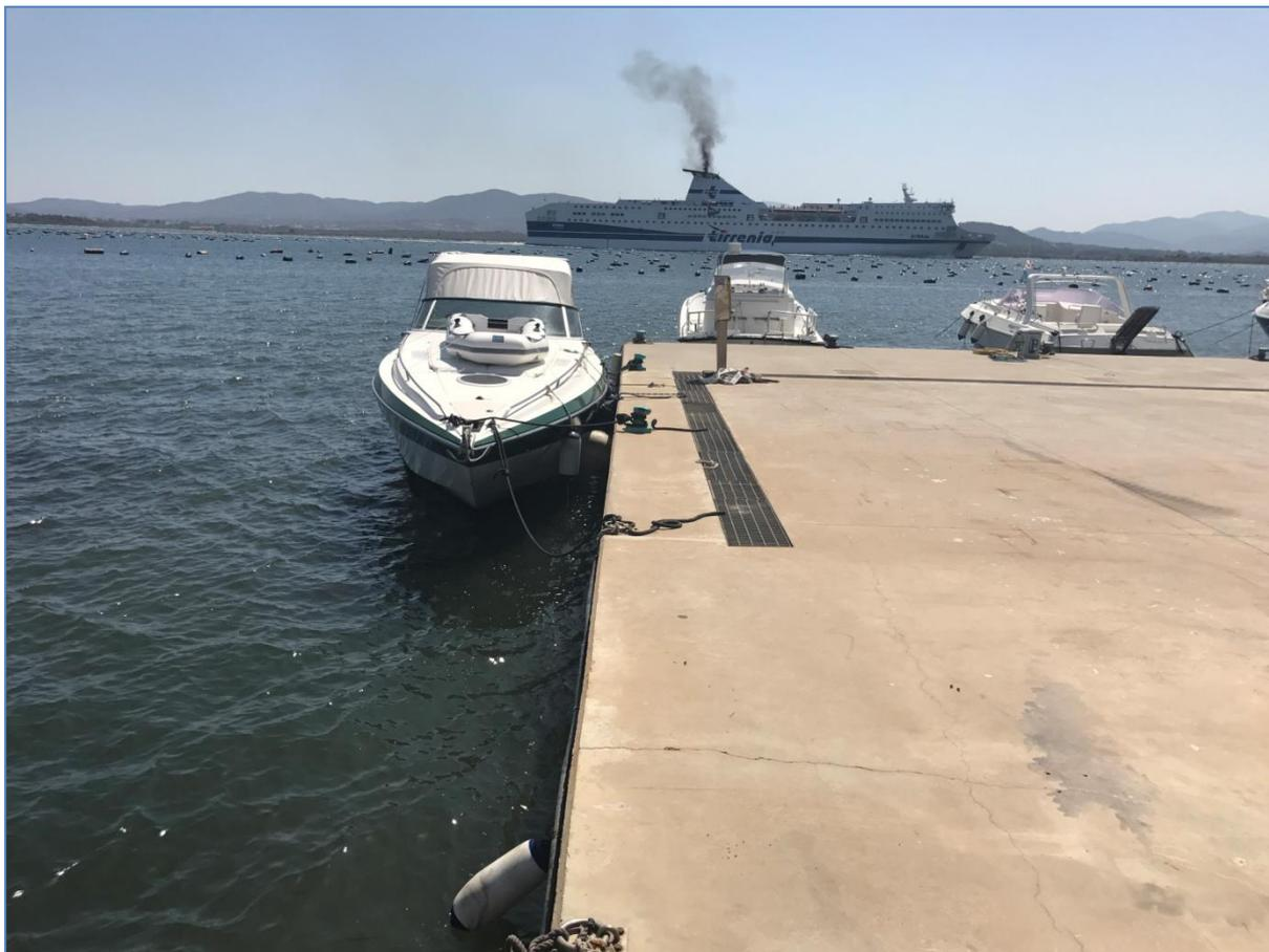
**Figura 2 Canaletta esistente per la raccolta acque di prima pioggia**
