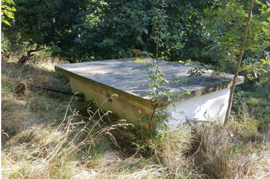
Foto 15 - Vasca di accumulo dotata di pompa a servizio della sorgente S358.
