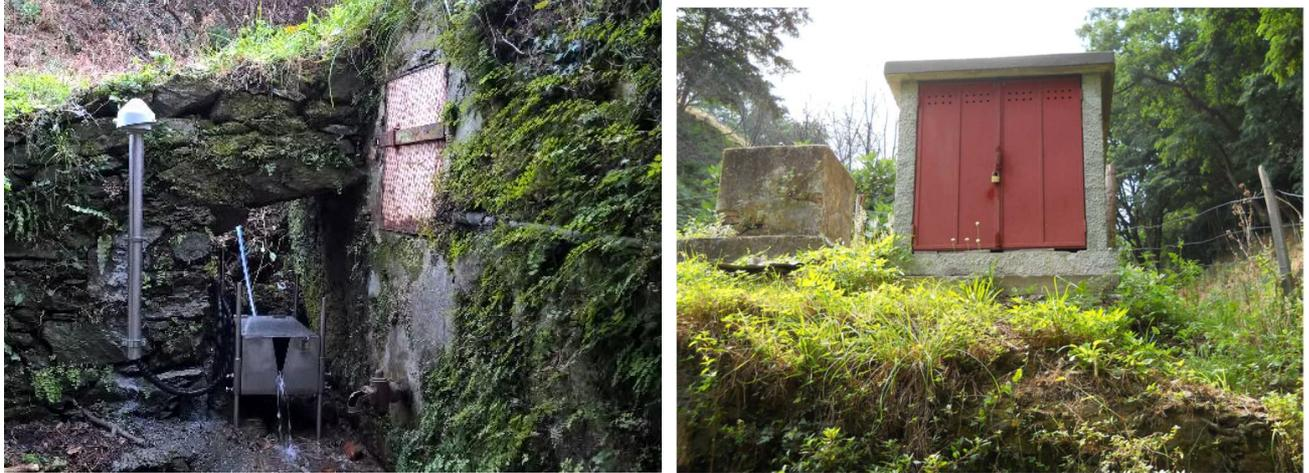
Foto 3 - Bottino di presa della sorgente S247 e misuratore di portata con stramazzo recentemente installato (immagine a sinistra). Serbatoio di accumulo con impianto di sollevamento a servizio della sorgente (immagine a destra).
