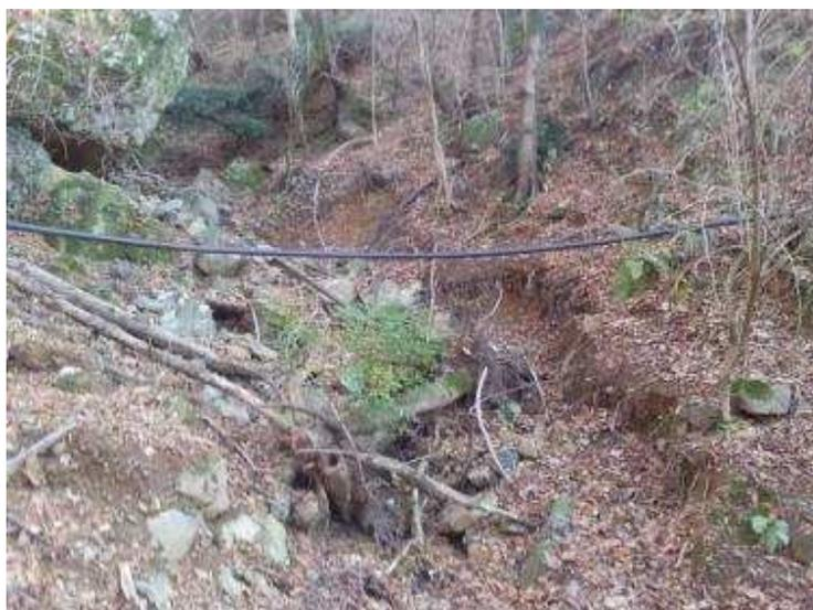
Foto 27 - Tratto non interrato dell'acquedotto tra la sorgente S353 e la località Cassinelle (si noti la vulnerabilità del tubo in corrispondenza dell'attraversamento del fosso naturale).
