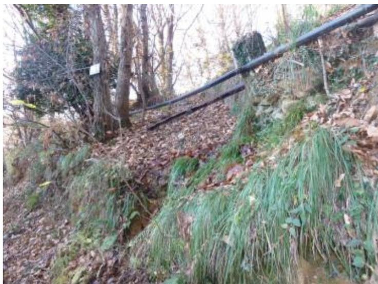
Foto 26 - Perdita nel tratto non interrato dell'acquedotto tra la sorgente S353 e lo località Cassinelle (si noti più in basso il vecchio tubo metallico dismesso già sostituito con il tubo in Pead).
