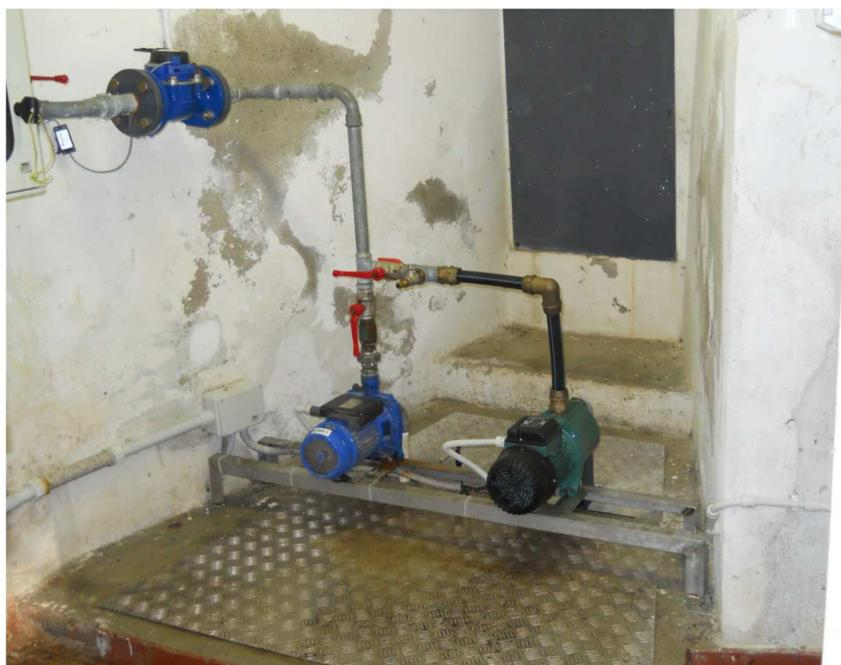
Foto 2 - Opera di presa della sorgente S165 con relative pompe.
