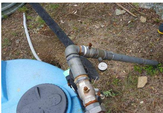
Foto 22 - Serbatoio e stazione di sollevamento presso la captazione dal sondaggio inclinato VB7 bis.
