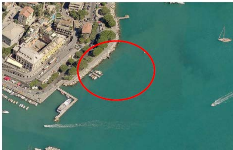
ZONA N12 – stato attuale
