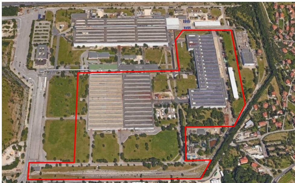
Figura 2 Area destinata ad ospitare le strutture dell' Interporto di Trieste S.p.A.
