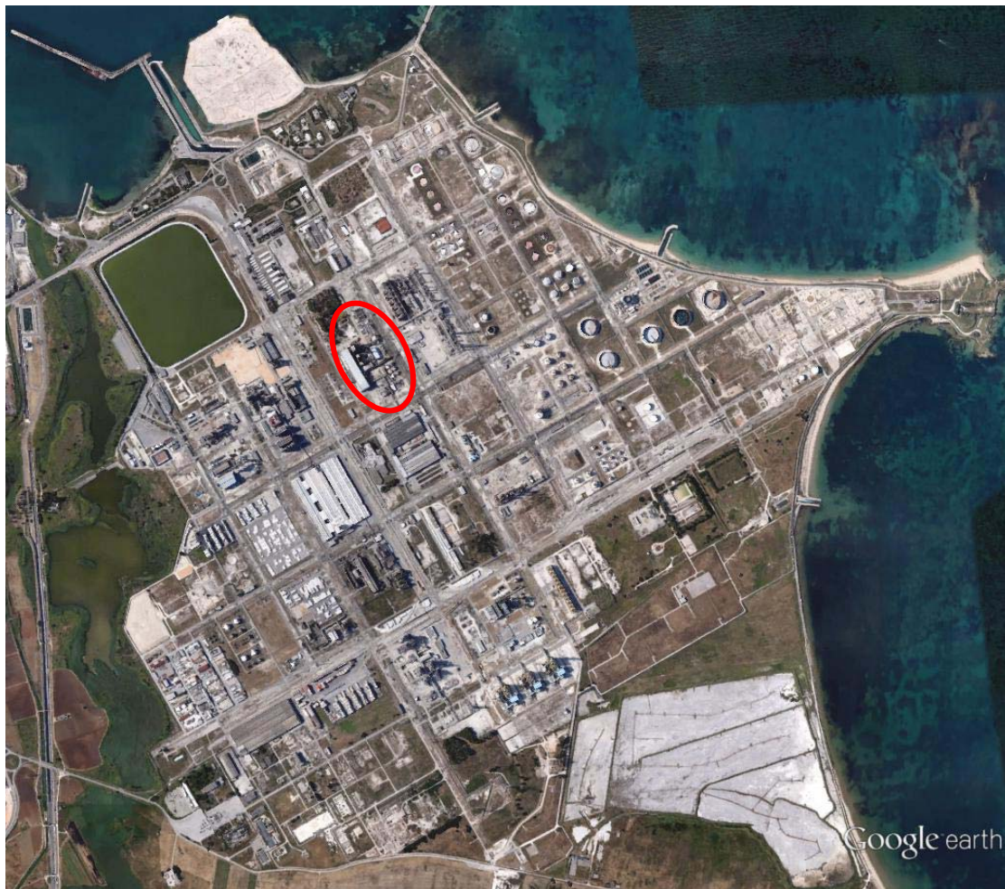
Figura 1 – Sito multisocietario di Brindisi. Nell’ovale rosso evidenziata l’area dove è localizzato il sistema di produzione acqua demi di Enipower
