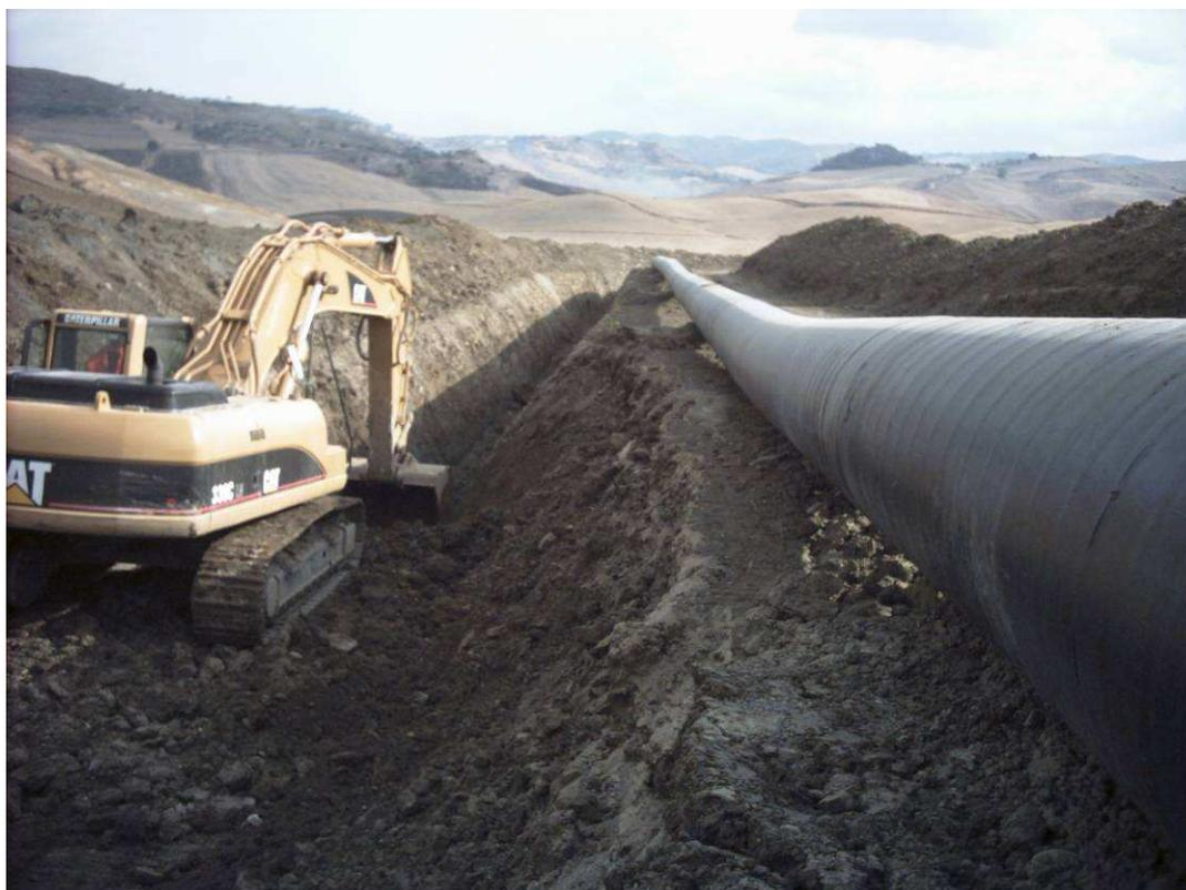
**Fig. 6.2 - Scavo per l'alloggiamento della condotta.**
