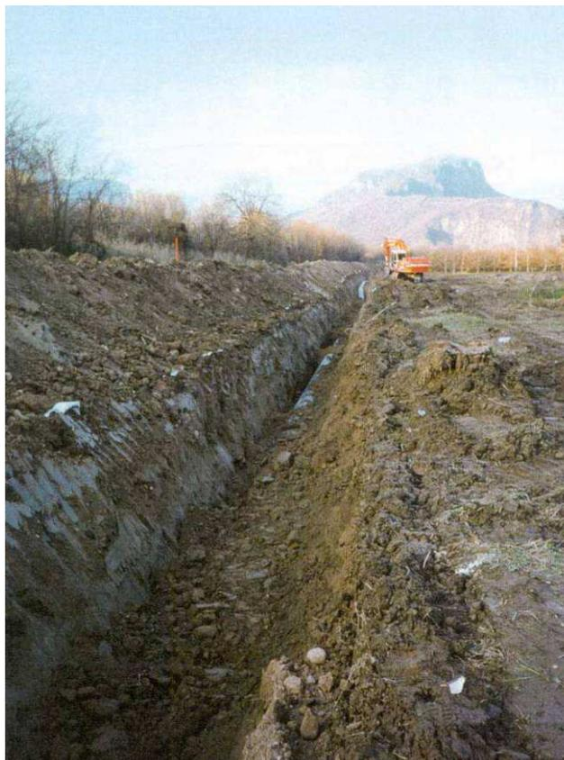
**Fig. 6.3 - Operazione di rinterro della condotta.**
