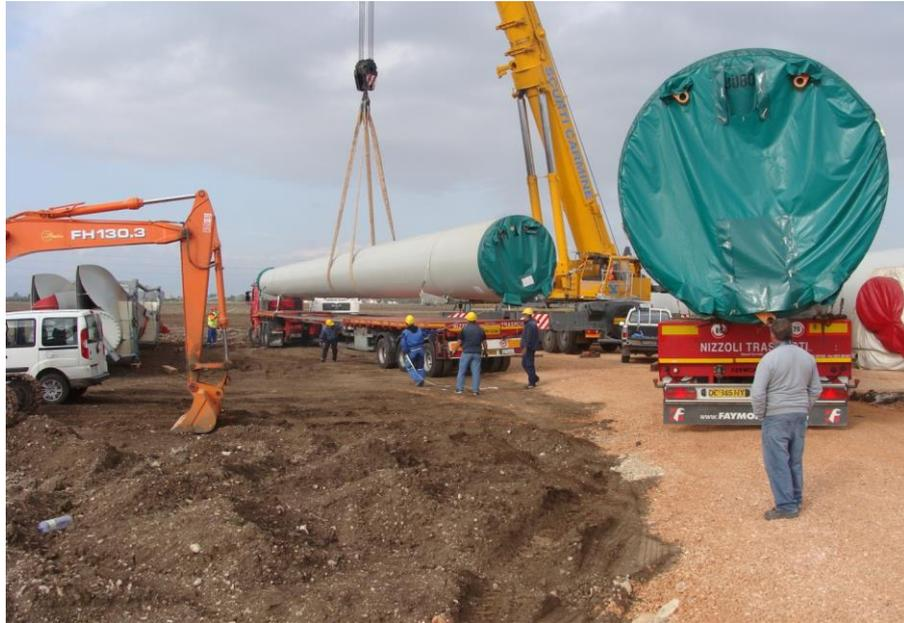
**Figura 6:** elementi torre smontata da trasportare
