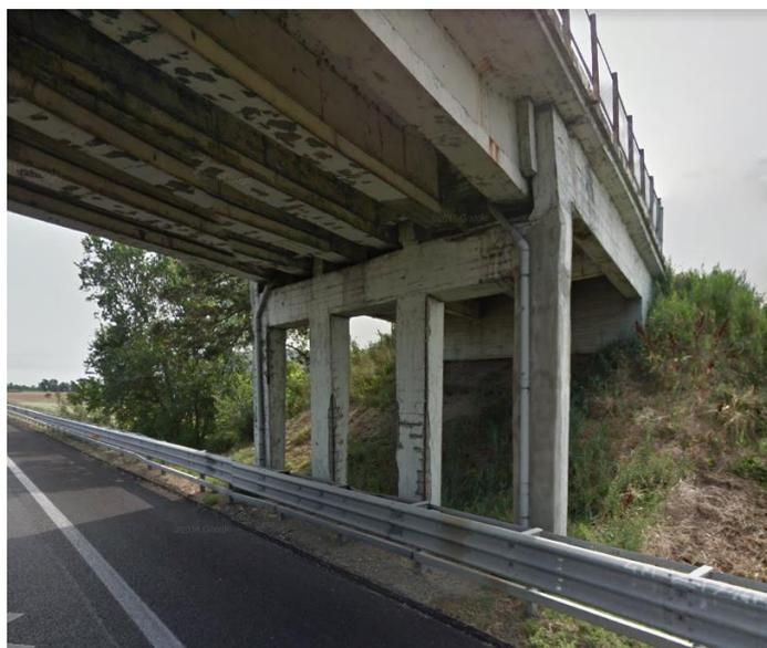
**Figura 4-2** – Vista spalle, pile e intradossate impalcate esistenti tipologiche
