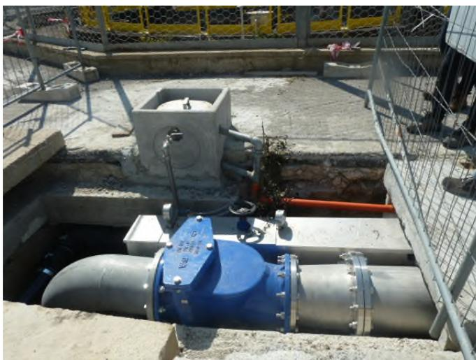
Figura 2-6 Vista della nuova condotta di veicolazione effluenti liquidi in corrispondenza della sezione di innesto e dei pozzetti di controllo
