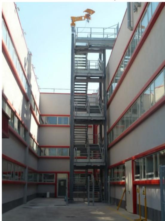
Figura 2-3 Vista della scala di servizio per l'accesso all'edificio Turbina
