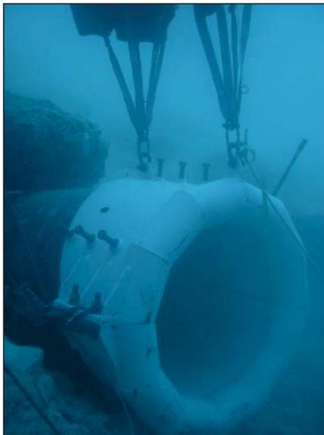
**Figura 24 – Installazione tipica di un *bellmouth* nel punto di uscita del microtunnel**
