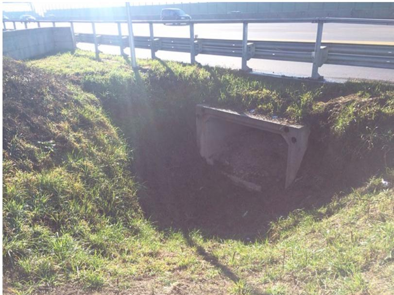
Fig. 5: imbocco nord, un eccesso di materiale di riporto occlude parzialmente l'accesso
