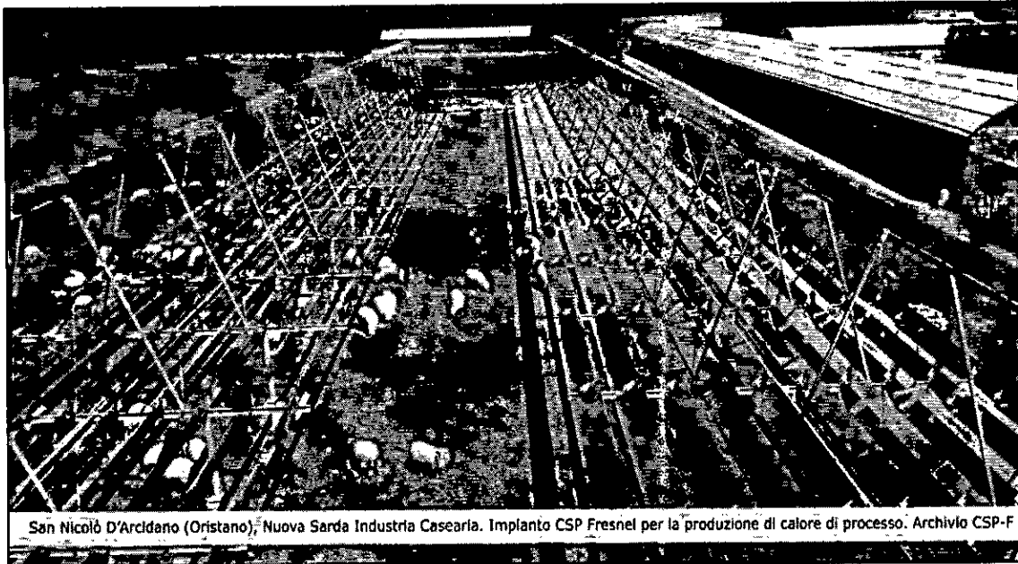
San Nicolò D'Arcidano (Oristano), Nuova Sarda Industria Casearia. Impianto CSP Fresnel per la produzione di calore di processo. Archivio CSP-F
