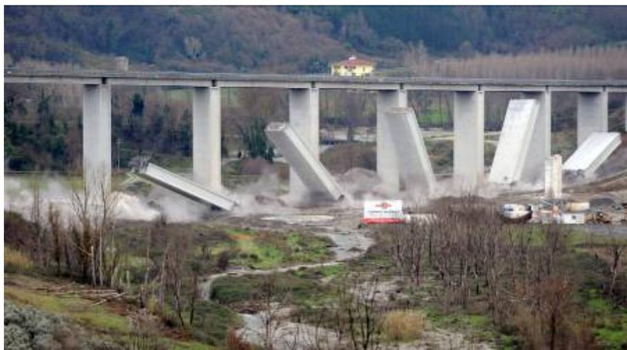
**Figura 12: esempio di pile demolite con esplosivo (foto archivio General Smontaggi)**
