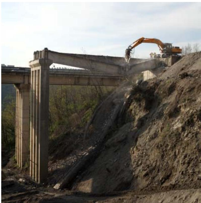
**Figura 9: esempio di una trave demolita per crollo (foto archivio General Smontaggi)**
