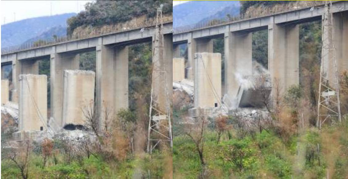
**Figura 7: esempio di una pila demolita per crollo indotto (foto archivio General Smontaggi)**
