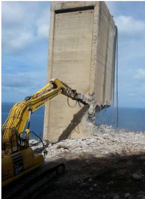
**Figura 6: esempio realizzazione di un cuneo di caduta (foto archivio General Smontaggi)**
