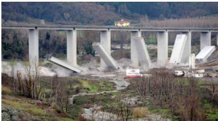
**Figura 8: esempio di pile demolite con esplosivo (foto archivio General Smontaggi)**
