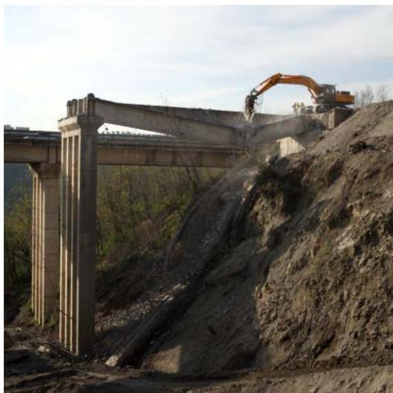
**Figura 5: esempio di una trave demolita per crollo (foto archivio General Smontaggi)**
