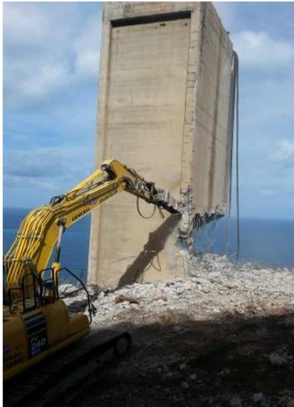
**Figura 10: esempio realizzazione di un cuneo di caduta (foto archivio General Smontaggi)**
